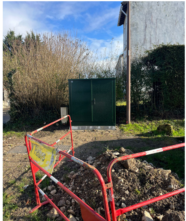
Installation d'une nouvelle armoire rue Solange Catez
