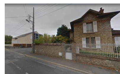
Bâti patrimonial et programme réalisé (Résidence Vert Domaine) à l'est de la ZAC, perception depuis l'avenue Charles Monier.
