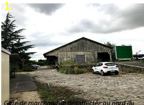
1. Gare de marchandise désaffectée au nord du bâtiment voyageur.
