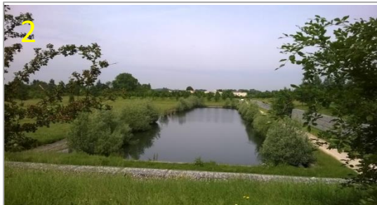
Les grands bassins de recueil des eaux pluviales de la Plaine du Moulin à Vent offrent de très larges dégagements dans le paysage.
