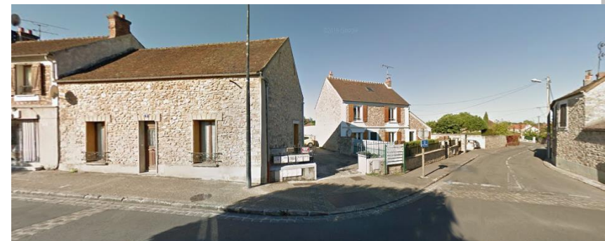
Bâti rural à l'intersection de la place Verneau et de la rue du Gros Caillou.
