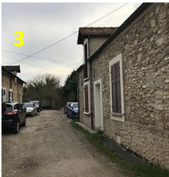
Bâti rural traditionnel,
