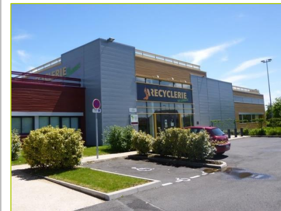
La Recyclerie du Lombric (9 rue de la plaine de la Croix Besnard - Parc d'activités à Vaux-le-Pénil)
