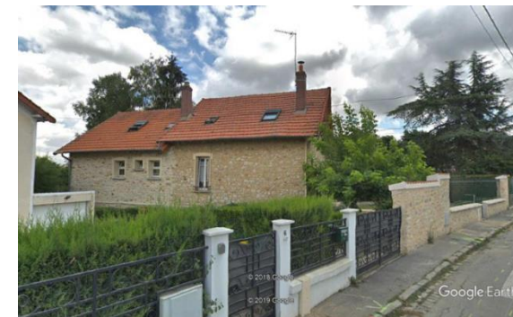
Perception depuis l'Ouest de la rue du Gros Caillou
