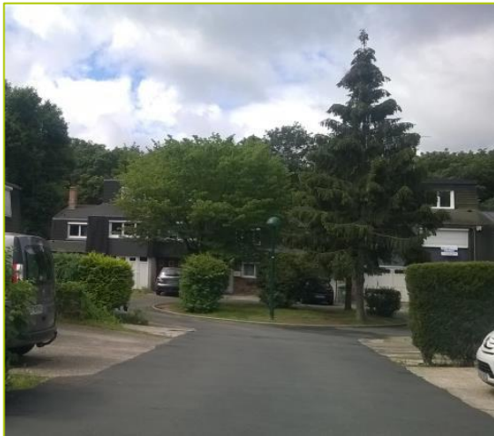
Le lotissement 334 dans la ZAC Cesson- Grand- Parc à Cesson-la-Forêt, un ensemble homogène, possédant des voies en impasse.
