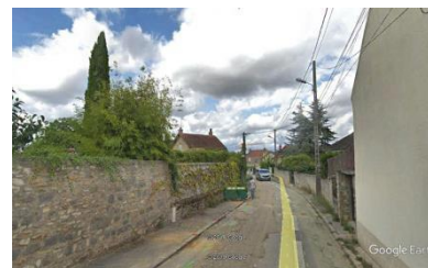
Mur de clôture rue du Gros Caillou
