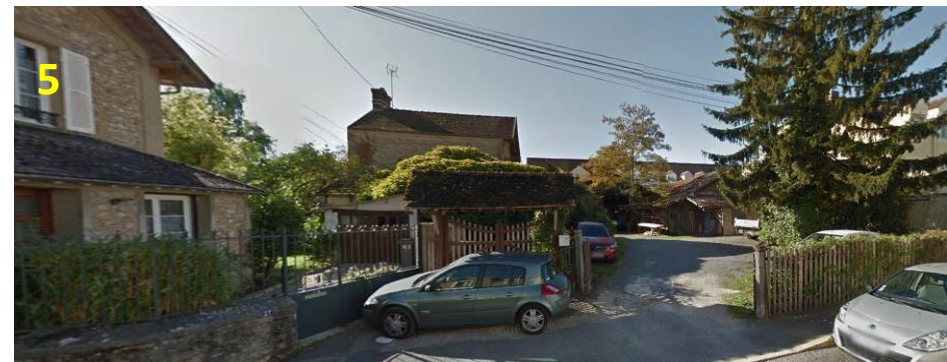
Ancien corps de ferme réhabilité, place Verneau
